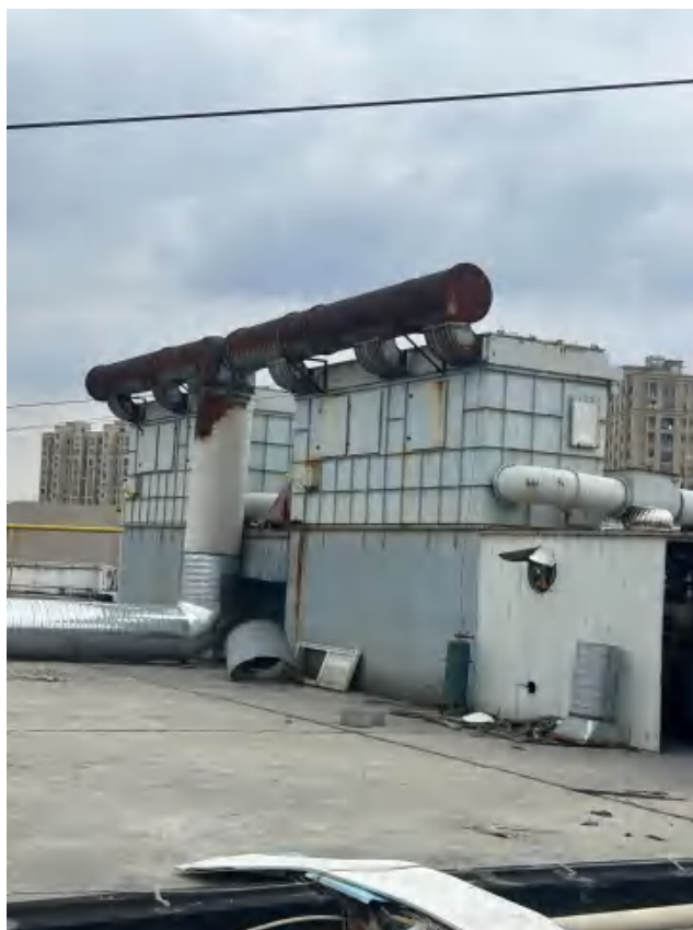
1-4#精加工生产线粉尘处理设施
