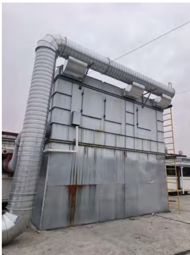
9-11#精加工生产线粉尘处理设施
