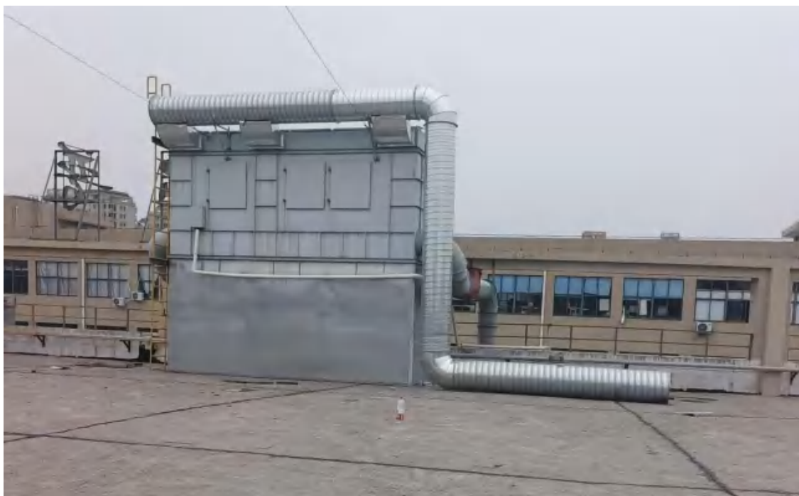
12-16#精加工生产线粉尘处理设施
