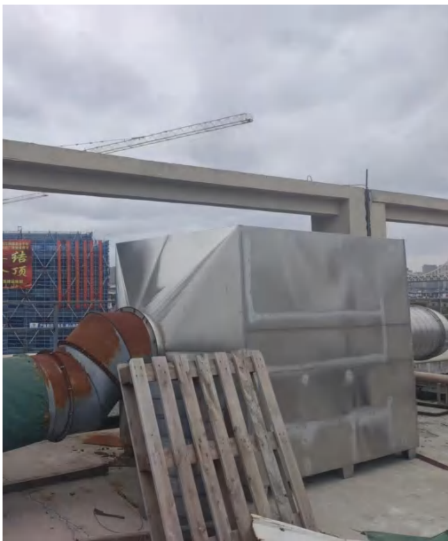
压塑、注塑废气处理设施
