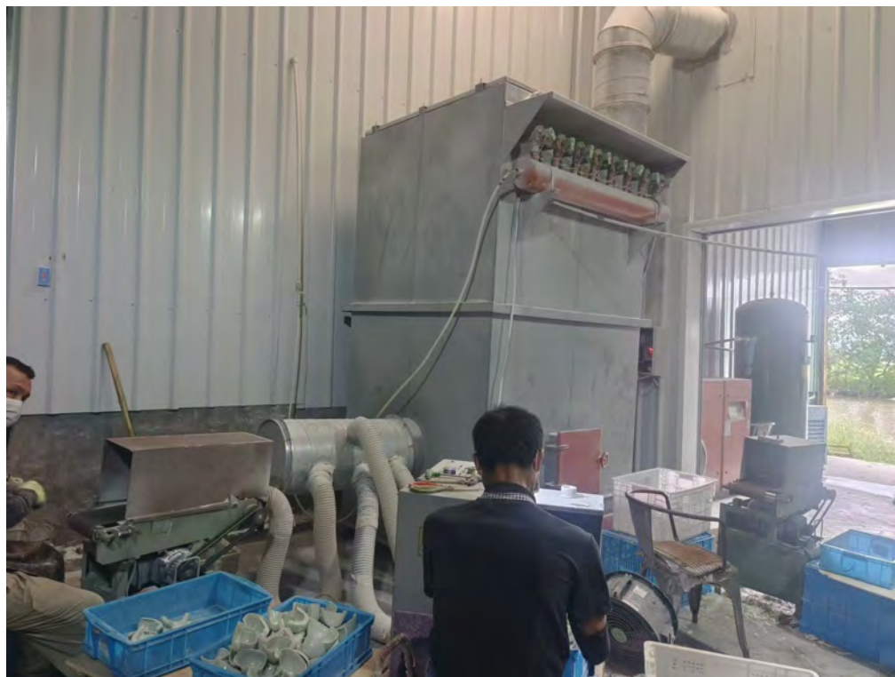
玻璃纤维复合材料烘软废气、模压废气、注塑废气处理设施（活性炭吸附）
