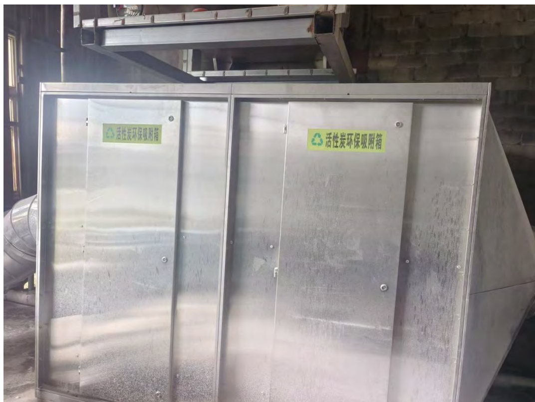
玻璃纤维复合材料烘软废气、模压废气、注塑废气处理设施（活性炭吸附）
