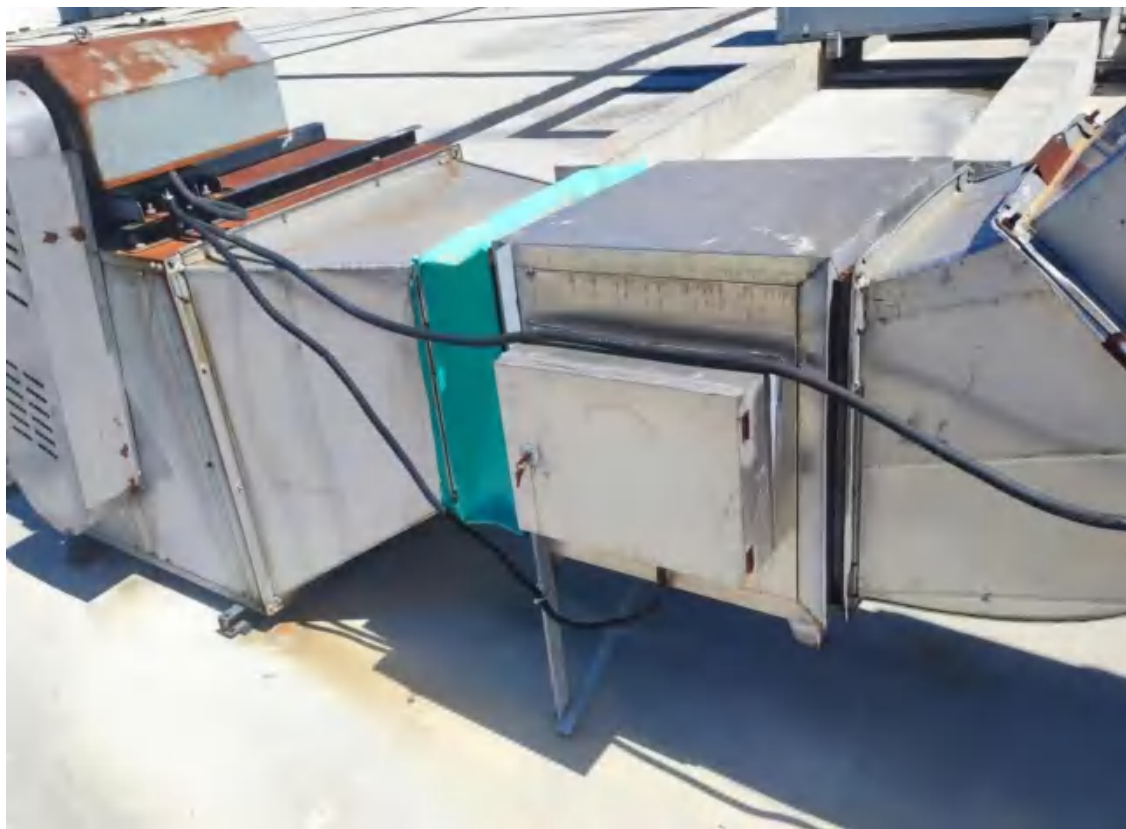
食堂油烟处理设施（静电式油烟净化器）
