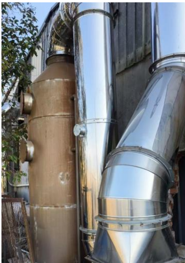
熔化、压铸烟尘，脱模废气处理设施（水喷淋）
