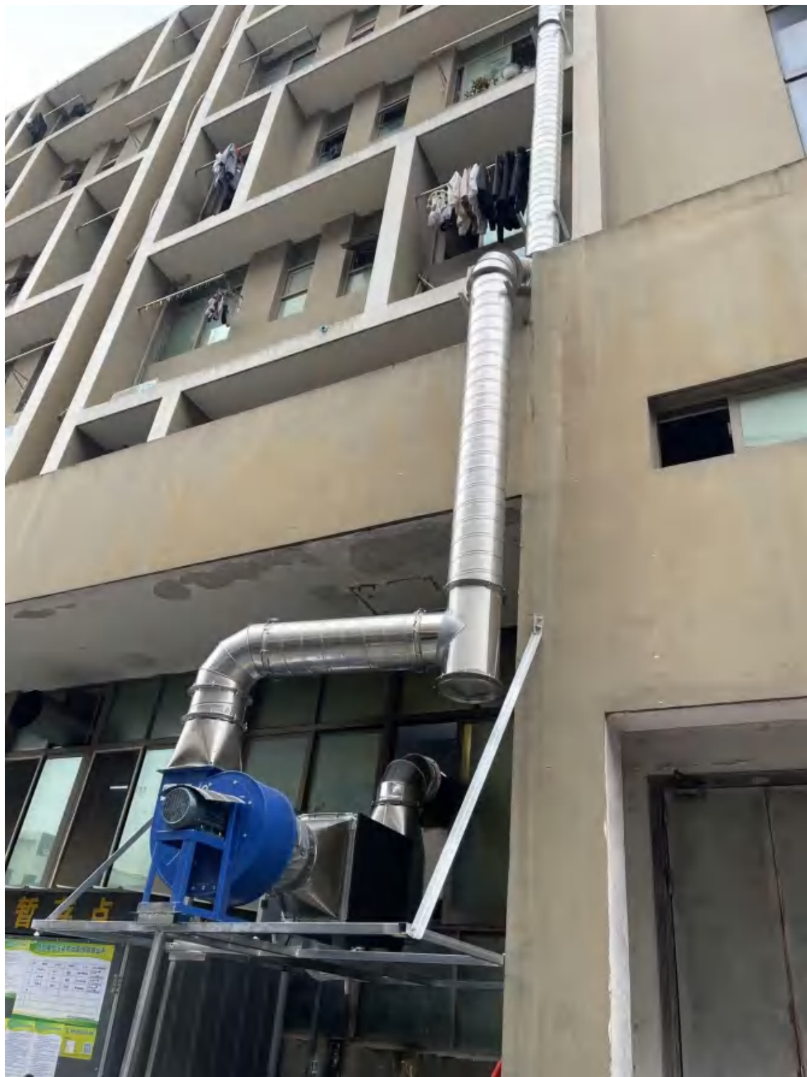
食堂油烟废气处理设施（油烟净化器）
