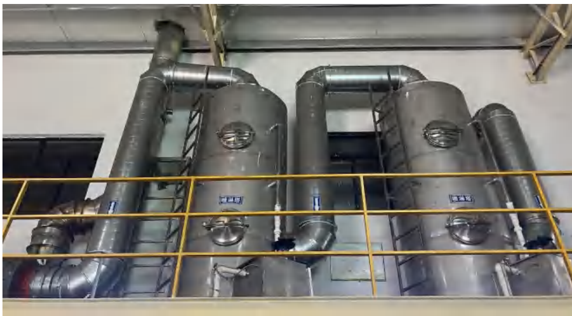
电泳废气处理设施（二级水喷淋）
