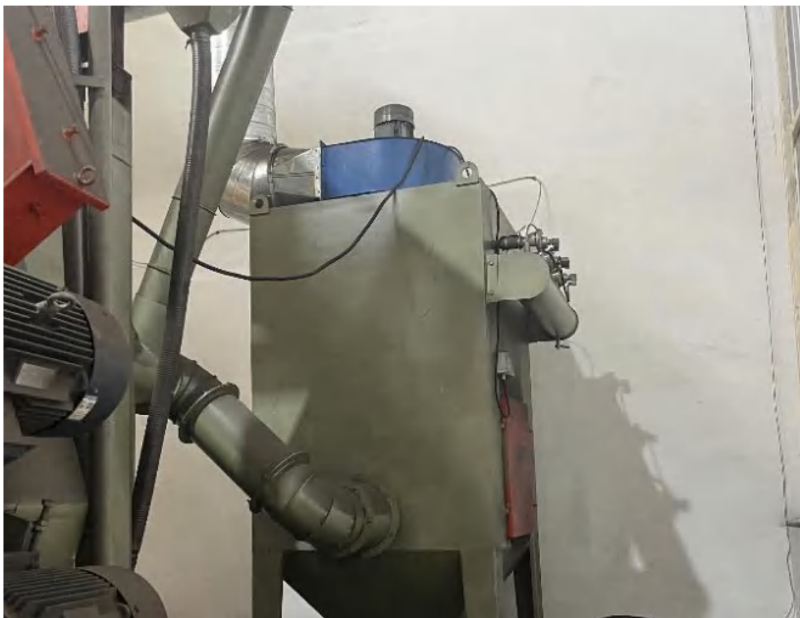
抛丸废气处理设施（布袋除尘）
